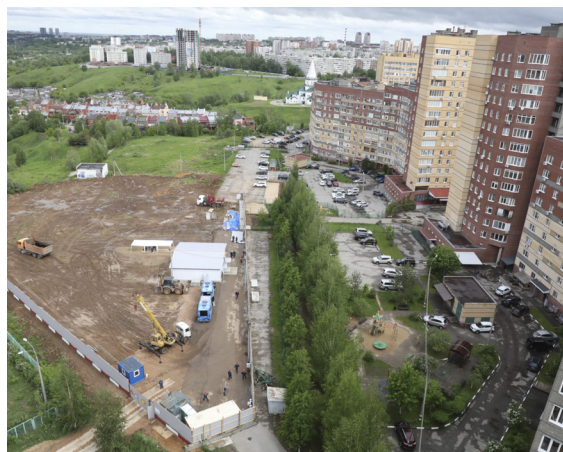
◀ Строительство «Школы 800» завершится к сентябрю 2021 г., занятия для школьников начнутся в год 800-летия Нижнего Новгорода
